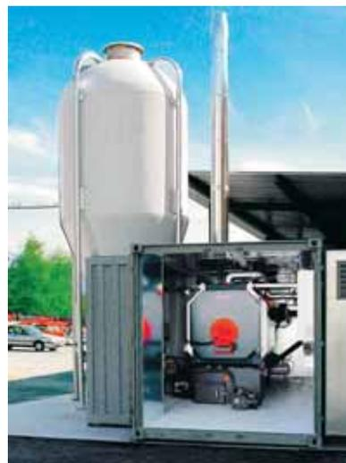
Solution tout-en-un dans un conteneur pour installation rapide en chantier.
