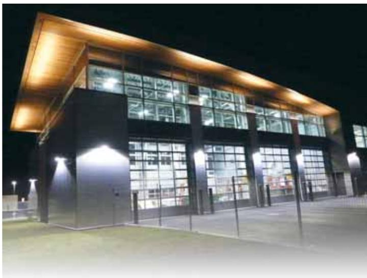
avec un système de façade ventilée en céramique. Il s'agit d'une technologie encore peu utilisée au Québec, selon monsieur Boilard. Ce système modulaire est constitué de panneaux de céramique qui s'imbriquent les uns dans les autres (aucun joint de mortier n'est exposé aux intempéries) et qui sont structurés par des composantes (extrusions) en aluminium. Il a permis de fermer rapidement les murs du bâtiment pour pouvoir poursuivre les travaux intérieurs dans des conditions optimales.
